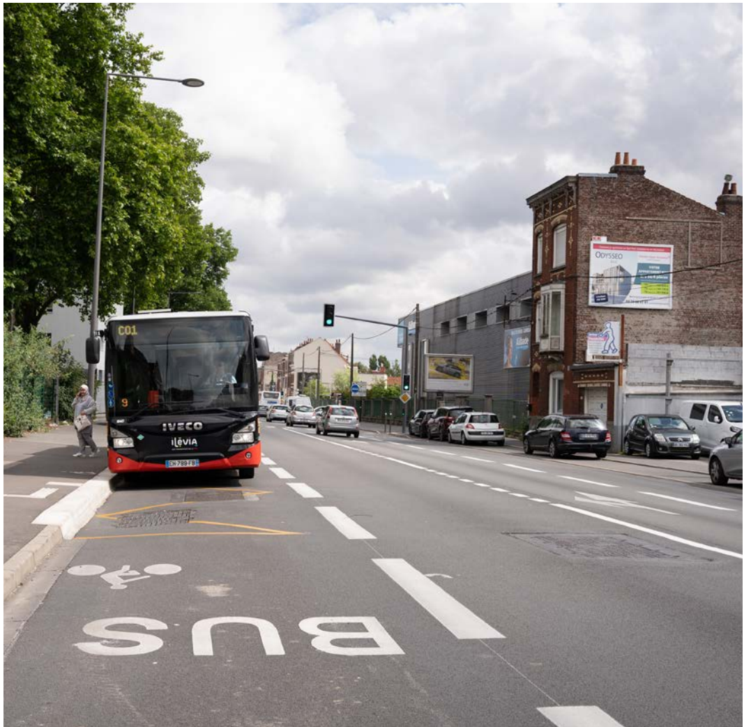
Voie de bus, rue du Faubourg d'Arras à Faches-Thumesnil ▲
