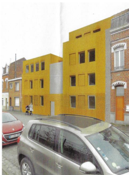
SNA Architecte – Lot 4 rue des Déportés Armentières
